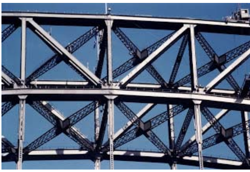
( De staalconstructie van de brug.)
