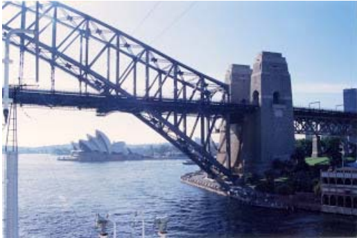
( Op iedere oever staan twee enorme torens die de overspanning van de brug ondersteunen.)
