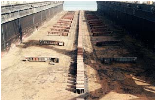
( Het dok naast ons werd gereed gemaakt voor een nieuw schip en hiervoor moesten de blokken op de juiste plaats komen te liggen.)
